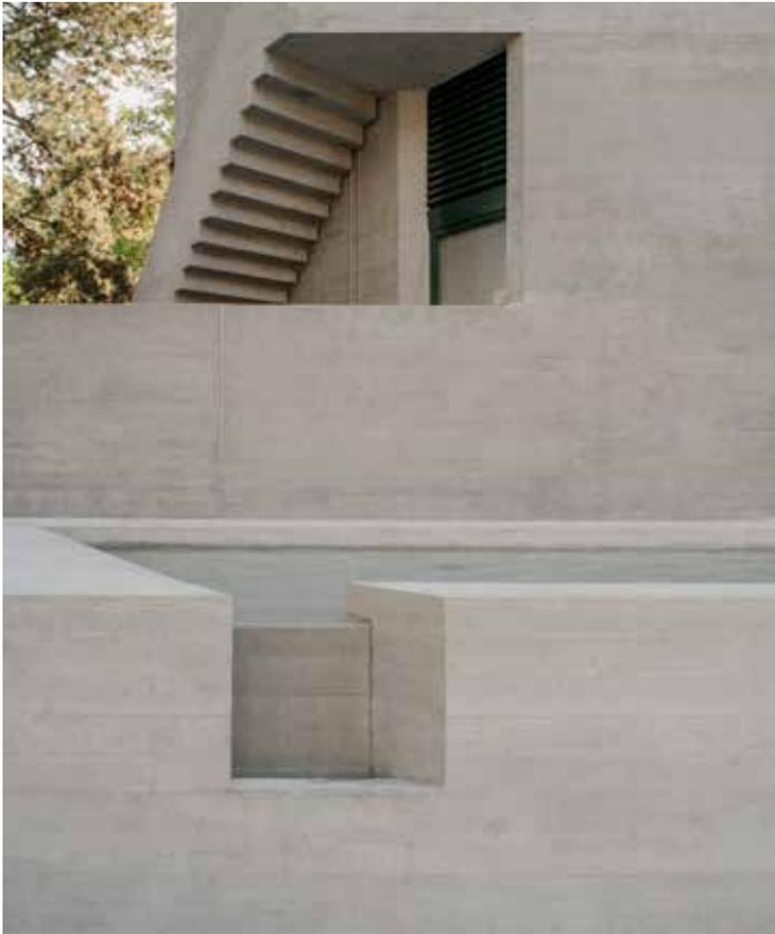
Die Entfernung der Witterungsspuren führte zu einem gleichmässigen Grauton. Einzig die Schalungsstruktur zeichnet sich ab.
