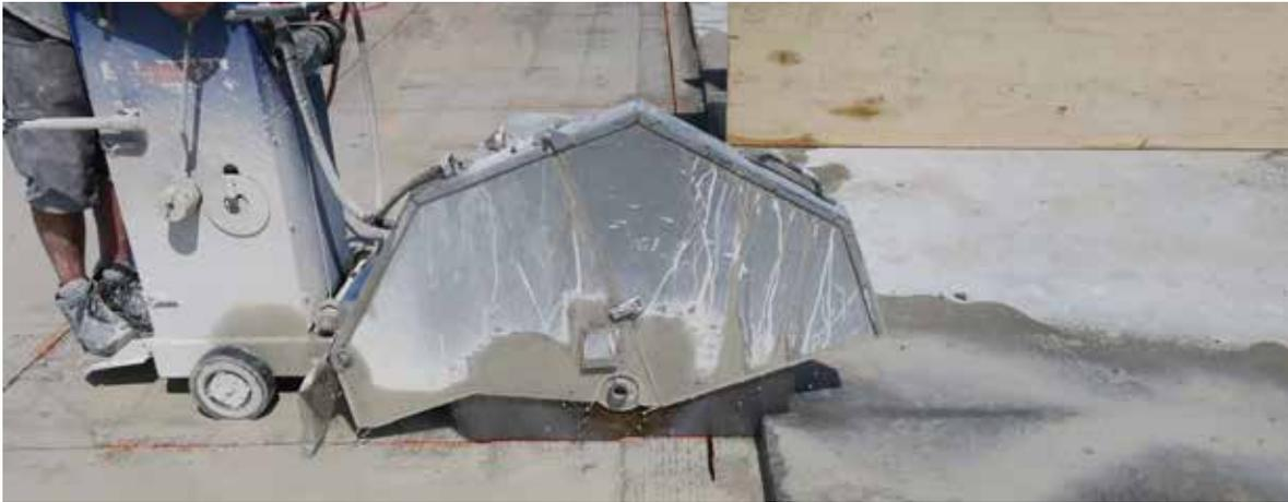
**Die Betonplatten werden vor Gebäudeabbruch am Stück herausgesägt und so wiederverwendet.**
