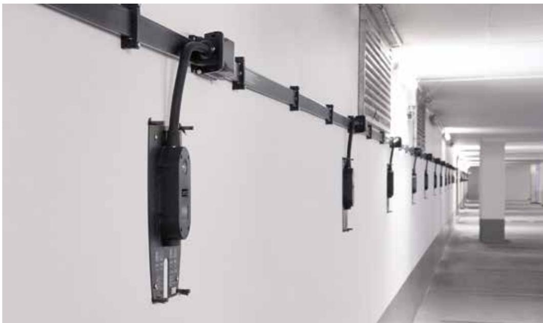
Mit der Installation von Rückplatten können jederzeit neue Ladestationen hinzugefügt werden, wenn der Bedarf nach Ladepunkten steigt.
